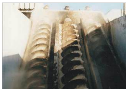
Trois pompes d'évacuation en fonctionnement avant la réparation
